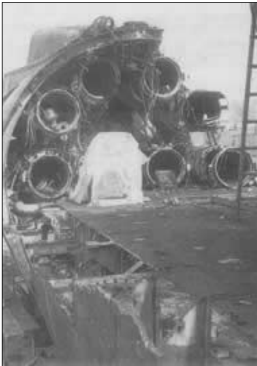
Blick auf die freigelegten Torpedoschächte
