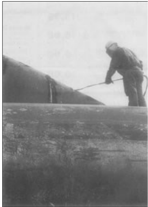
Mit Schneidbrennern wird das Boot in seine Einzelteile zerlegt
